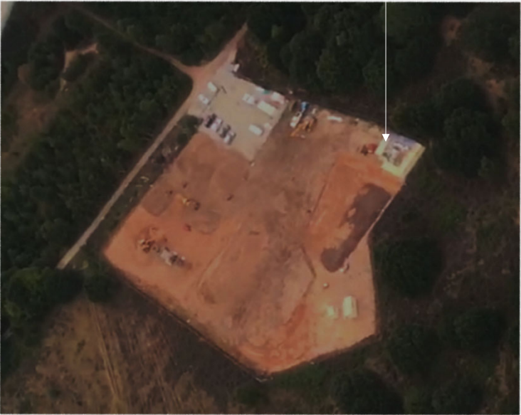
UXO demolition area
